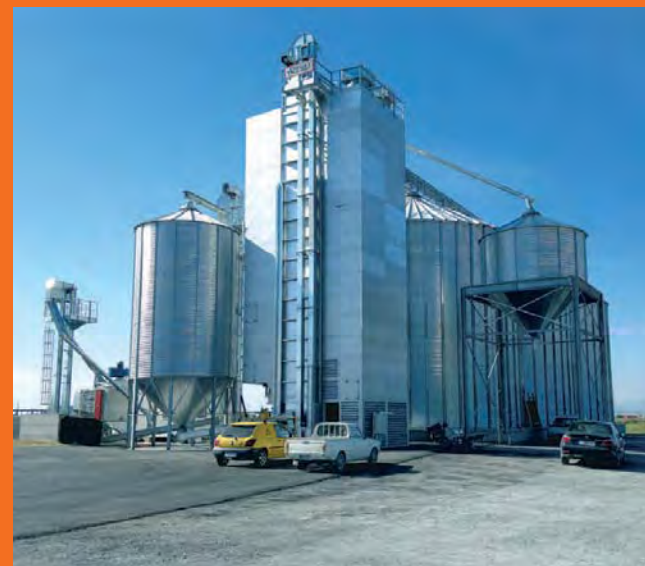
Impianto di essiccazione e stoccaggio con essiccatoio continuo 10 ton/h e batteria di silos (Salonico Grecia)
