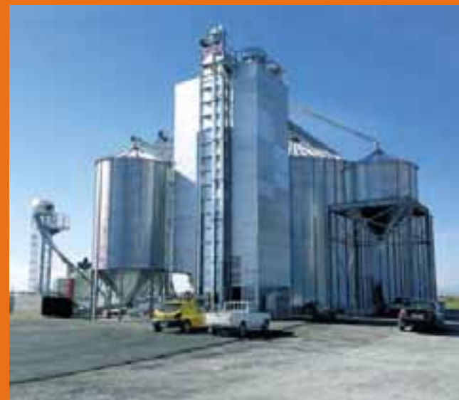
Impianto di essiccazione e stoccaggio con essiccatoio continuo 10 ton/h e batteria di silos (Salonico Grecia)
