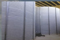
Batterie di 6 silos
