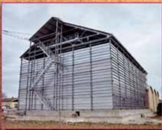
IMPIANTO DI STOCCAGGIO CON ESTRAZIONE AUTOMATICA DA TON 7000
