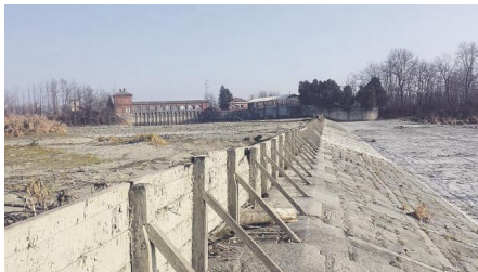
Siccità all'imbocco del Canale Farini dalla Dora Baltea a Saluggia
