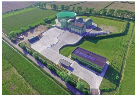
L'impianto per la produzione di fertilizzanti organici digestati da utilizzarsi sui terreni realizzati a Vellezzo Bellini
