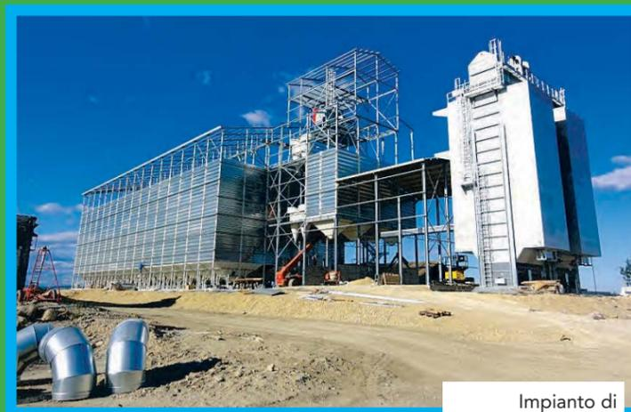
Impianto di essiccazione e stoccaggio da 7300 Ton
