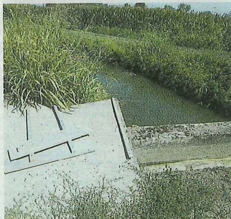
La paratia in legno staccata per far defluire l'acqua
